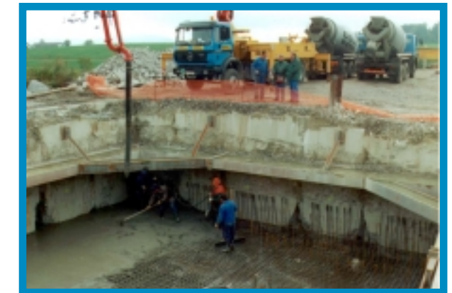
Seeklause, Betonieren der Bodenplatte, Oktober 1997
