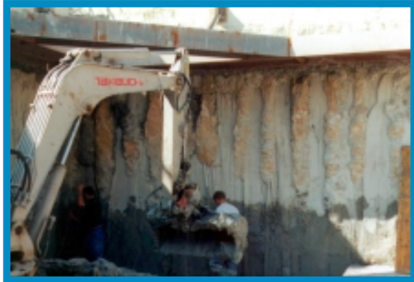
Beim Aushub der Seeklause wurden die Kalk- und Zementsäulen der Bodenstabilisierung sichtbar, August 1997
