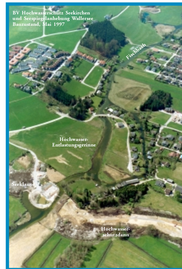
Der Kernbereich des Bauvorhabens 1997
