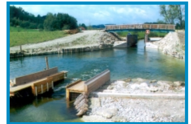
Seeklause mit Bootsgasse nach Baufertigstellung, Juli 2000
