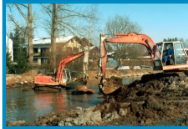
Die Fischach im Seemoos, Baggerungsarbeiten im Februar 1998
