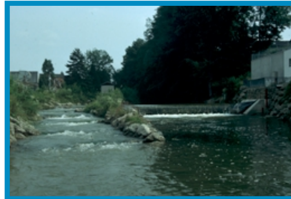
Schlauchwehr mit Fischpass, seit Dezember 1996 in Betrieb
