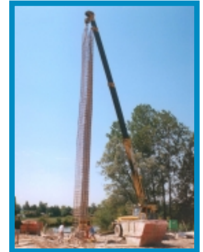
Einbau des Bewehrungskorbes für die Schlitzwand der Seeklause, August 1996
